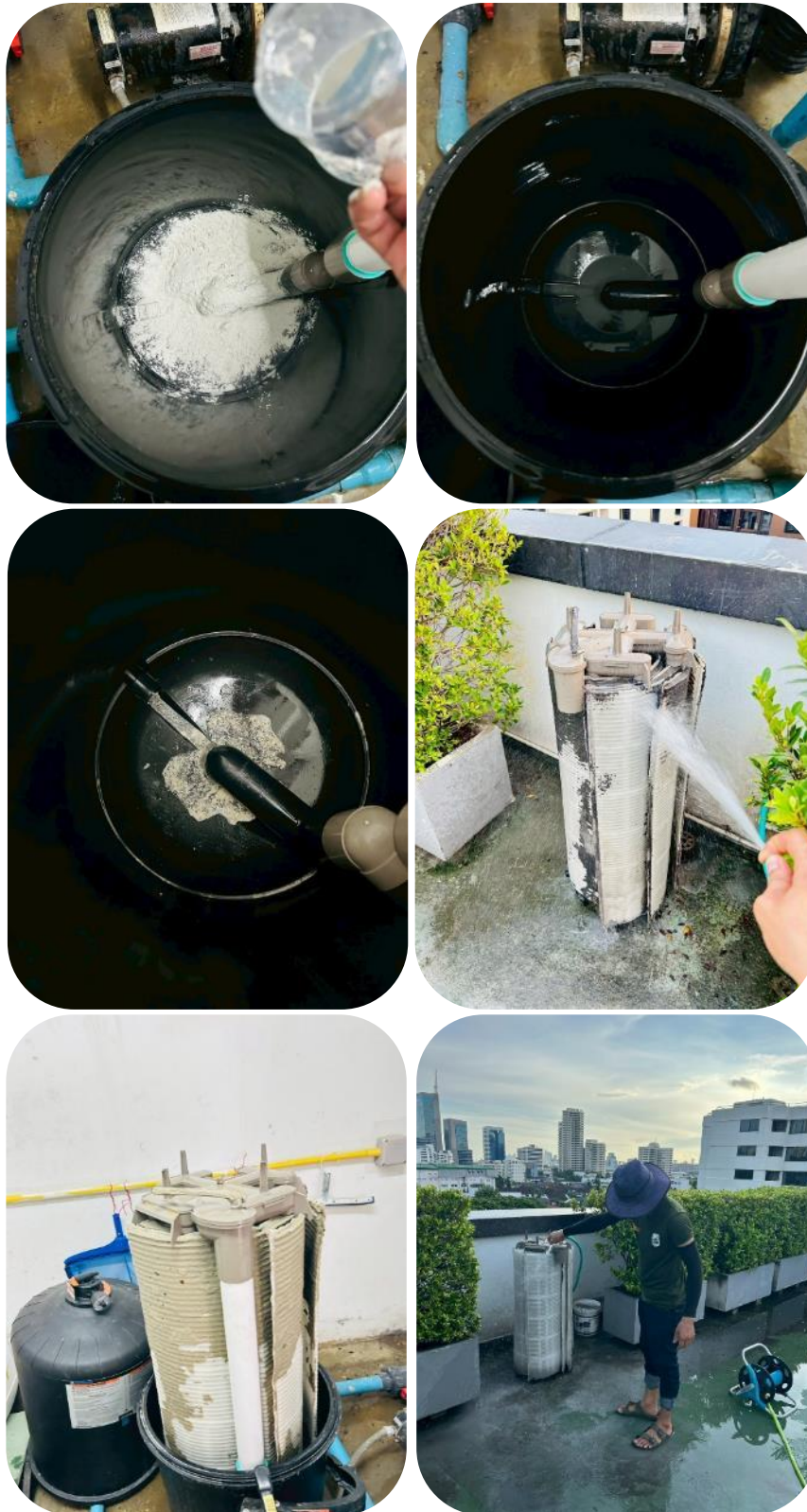
ภาพที่ 4.2-4 ทำความสะอาดถังกรองทรายน้ำ
